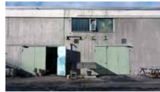
Auf der Kläranlage / Waste Water Treatment Plant ↳ Paul Kobert
